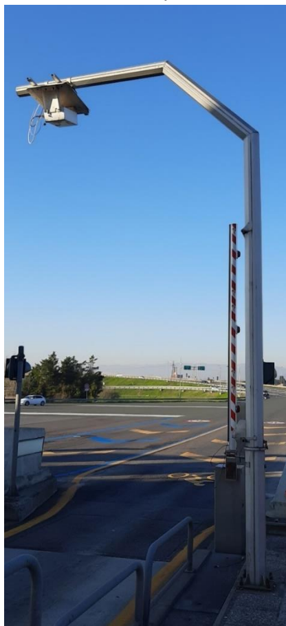
Figura 10: - A1 Casello Scandicci – Foto palo boa telepass.
