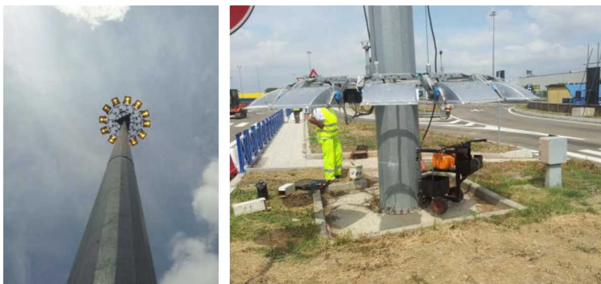
Figura 3 - Dettaglio corona mobile torre faro.
