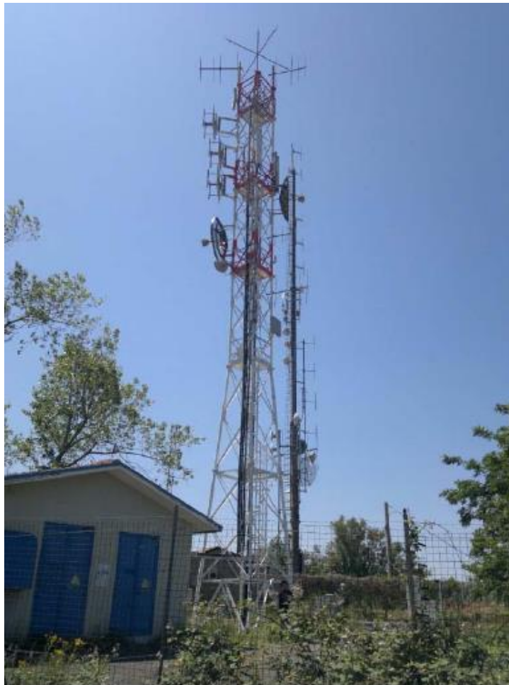
Figura 4 - Torre a traliccio per ripetitori.
